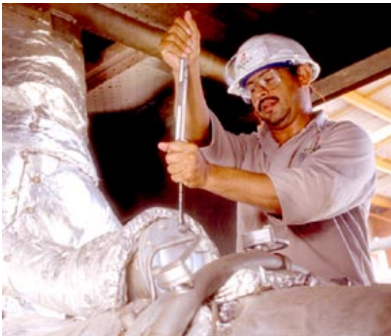
Red de ductos
