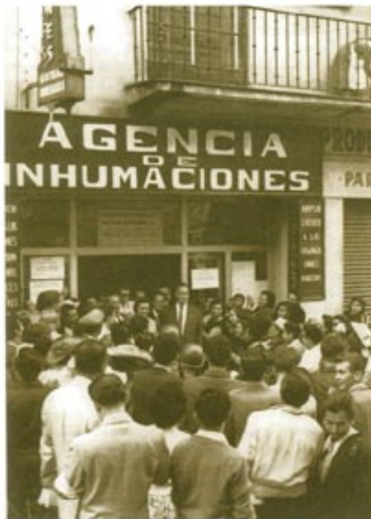
Fotografía s/n. Instalación de casilla en una Agencia de Inhumaciones. Archivo General de la Nación.
